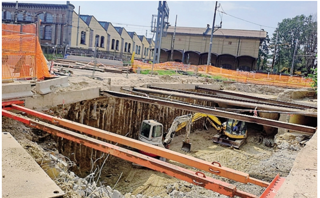
Lo su via Nino Dall'Oro: l'obiettivo è terminare i lavori entro la fine dell'anno Bagatta
