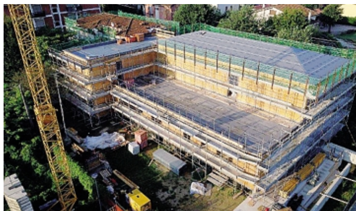
Il cantiere della nuova scuola a Castelgerundo
