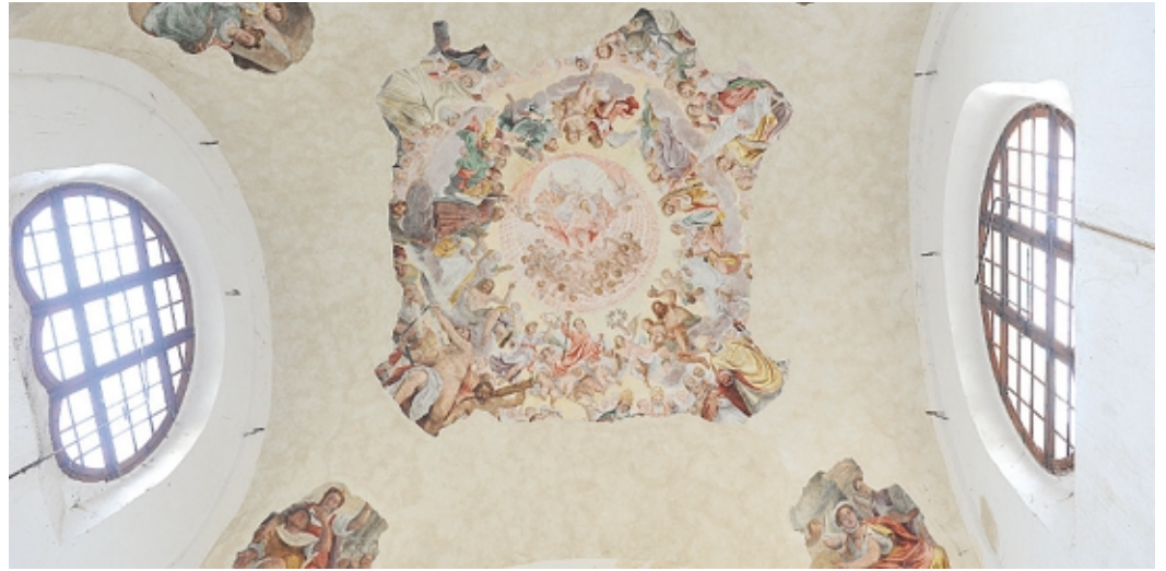
Scorcio interno dell'ex Cavallerizza che il Comune punta a trasformare in un hub culturale, ma l'iter non sarà breve
